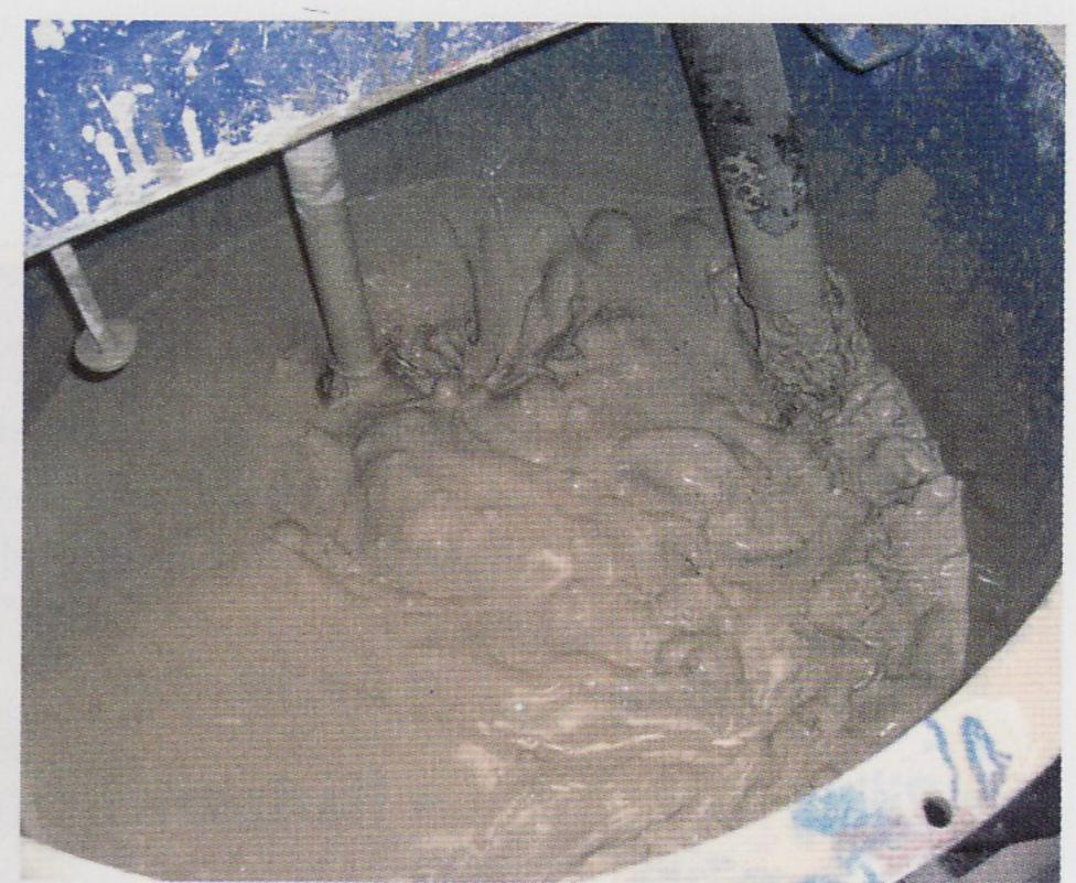
Anmischen von HDG Thermo HS im Kolloidmischer Typ IS-38-E. Die Beimischung von 440 Litern Wasser je 1.000 Kilogramm Spezialmörtel ergibt eine flüssige Suspension. | Fotos: HDG Umwelttechnik
