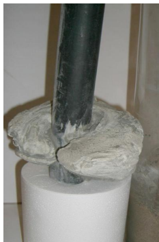
4. Injektionskörper am PE-Rohr
