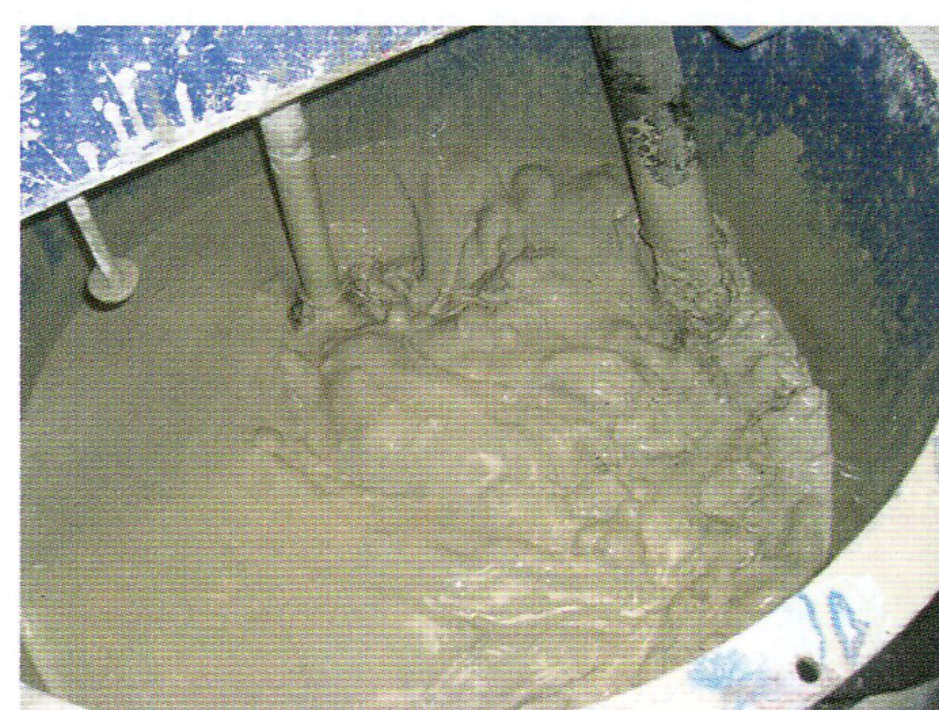
Anmischen von HDG Thermo HS im Kolloidmischer Typ IS-38-E. Die Beimischung von 440 Litern Wasser je 1.000 Kilogramm Spezialmörtel ergibt eine flüssige Suspension.
