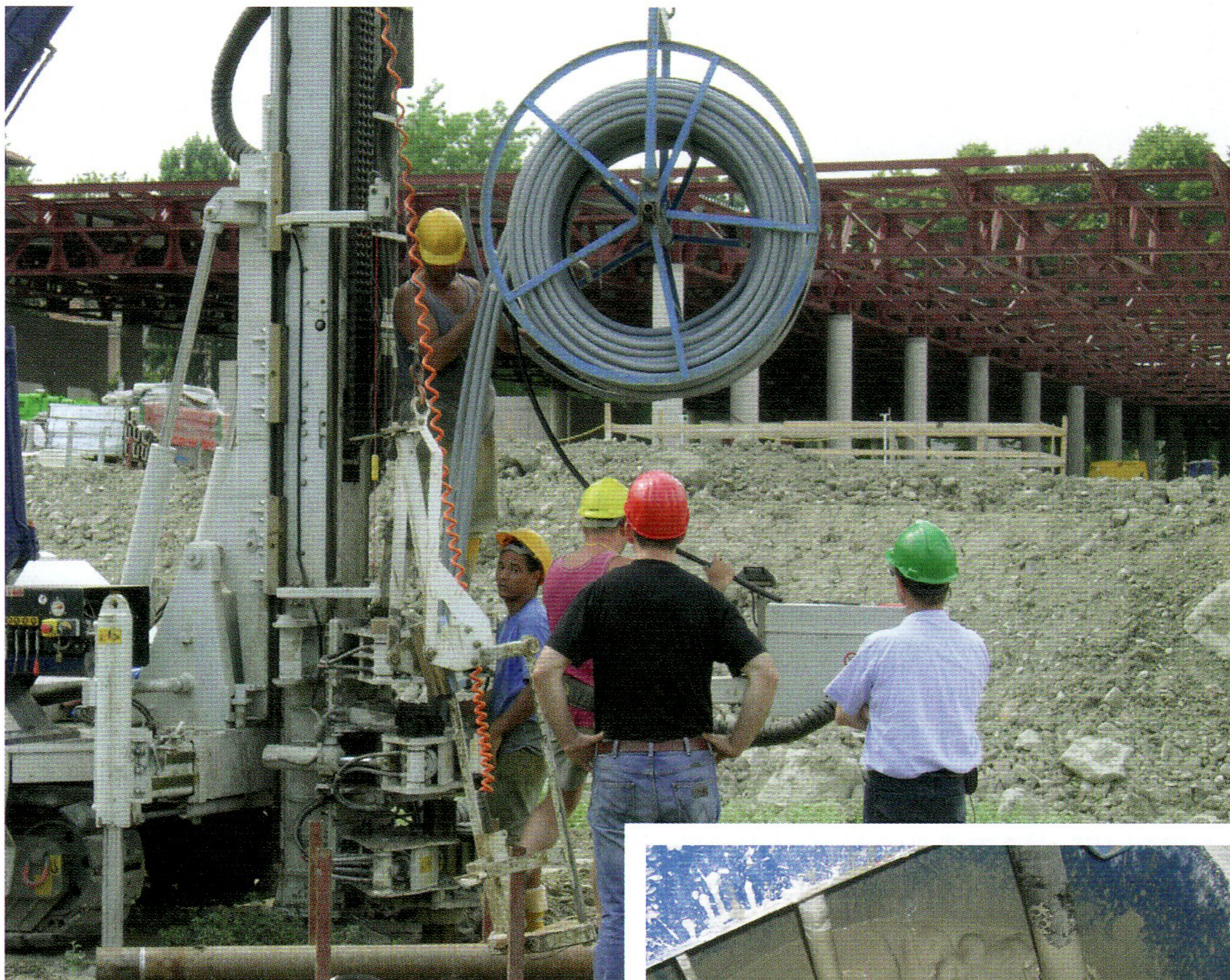
Einbau von EWS-Rohren auf einer Baustelle in Piacenza/Italien. | Fotos: HDG
