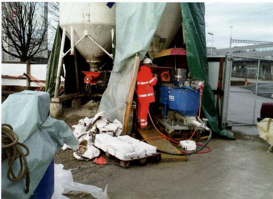
Silanlage für Verfüllmörtel HDG THERMO HS, Kolloidmischer mit vorgeschaltetem Nassaustrag
